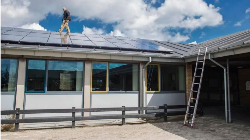
På en god solskinsdag dækker solcelleanlægget Sølystskolens strømbehov – og måske lidt til, oplyser serviceleder Egon Schmidt. Fotos: Casper Dalhoff
